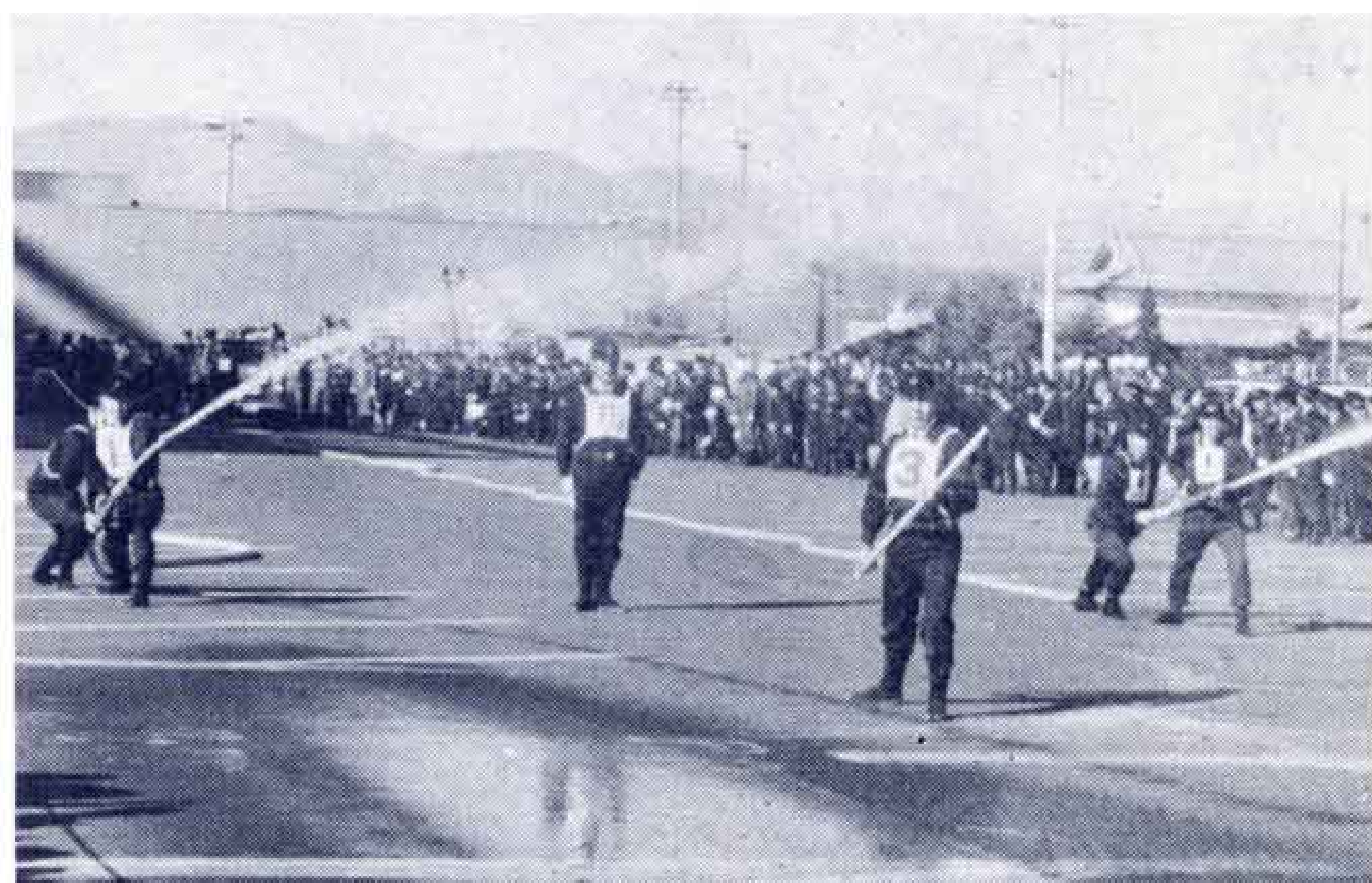
【民間自衛消防隊の放水訓練】
