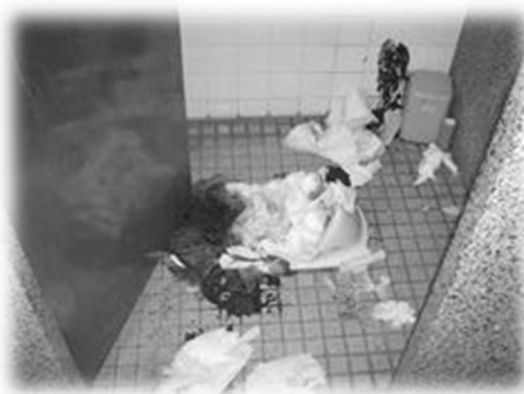
断水により汚れたトイレ
