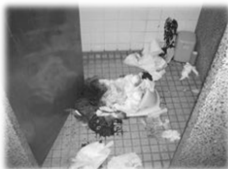
断水により汚れたトイレ
