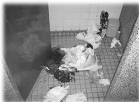
断水により汚れたトイレ
