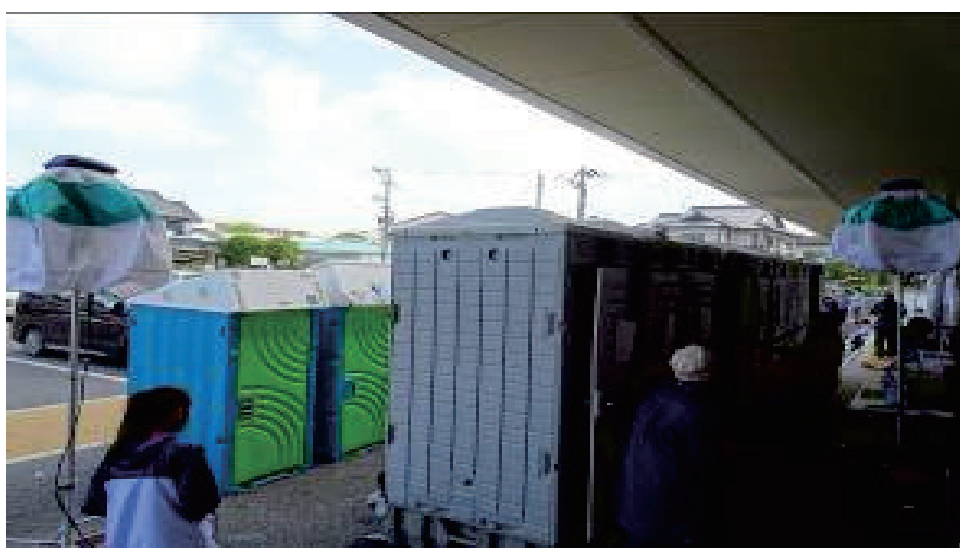
避難所に設置された仮設トイレ(平成 28 年熊本地震)
