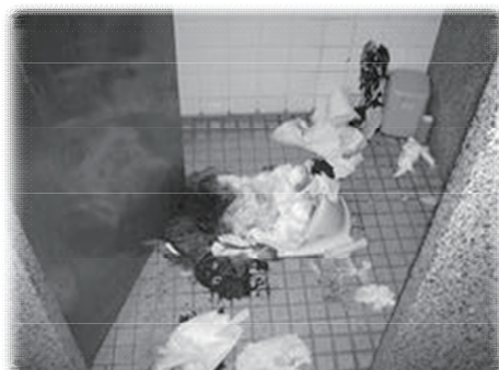
断水により汚れたトイレ
