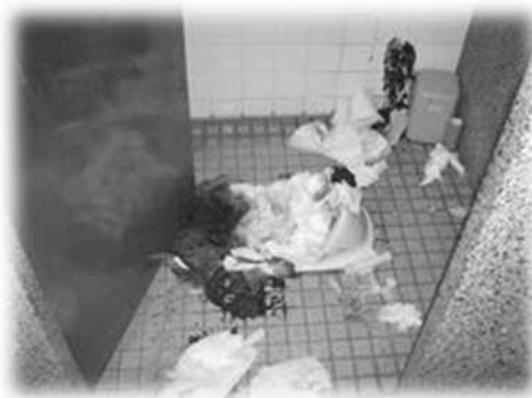
断水により汚れたトイレ
