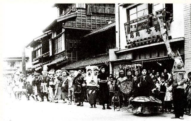
町内唯一木造3階建て
