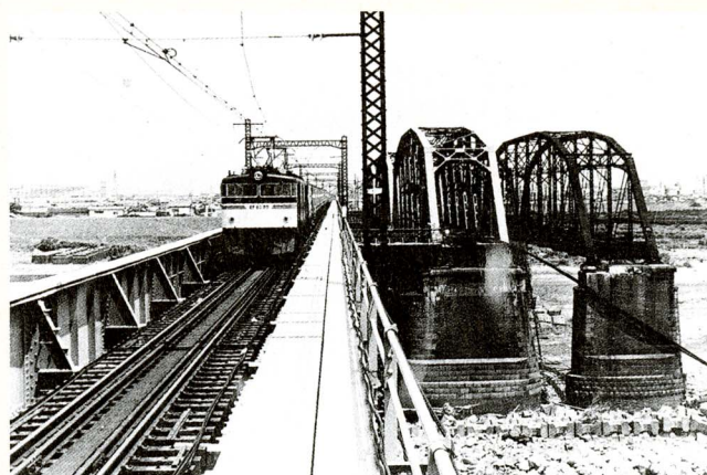
国鉄富士川橋一部流失
