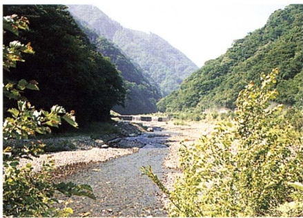
細くなる川幅と砂防ダム
