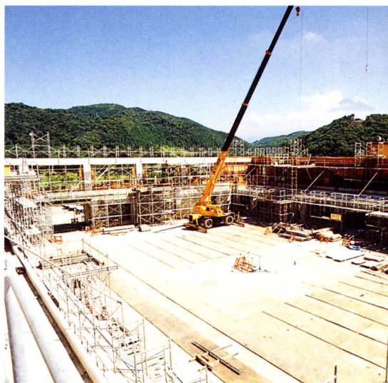
ものすごく大きな総合体育館、本体工事も着々と進んでいる…。
