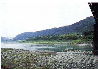
富原橋下流端(重要水防箇所Aランク)
