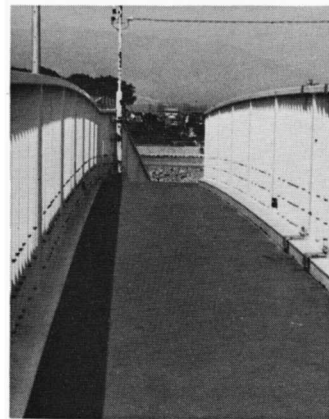
一坂下歩道橋 坂下区の子供会のみなさんが いつもきれいにしています
