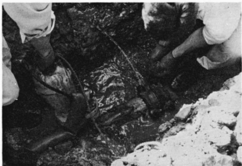
水道管の破裂を修繕する職員
