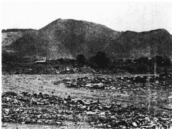
現在宅地造成中の日軽北松野団地と中野土地区画整理組合による中野地区団地予定地……ここに750戸が建設される。
