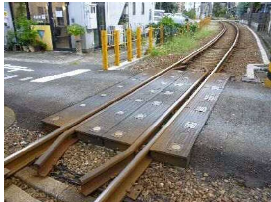
～踏切部の軌間改修～
