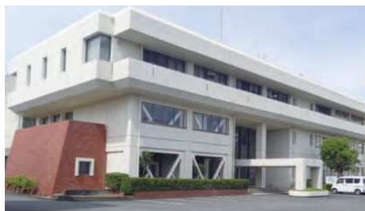
西部浄化センター
