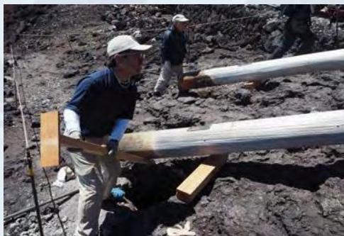
前回建てた鳥居の撤去（平成28年）
